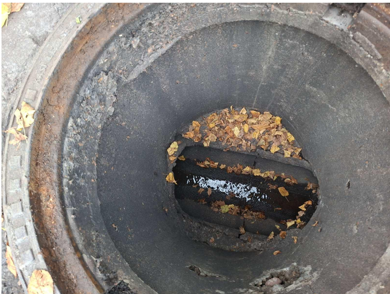
Priestočio g. ir Šaulių g. paviršinių nuotekų šulinių ir kolektoriaus apžiūra
